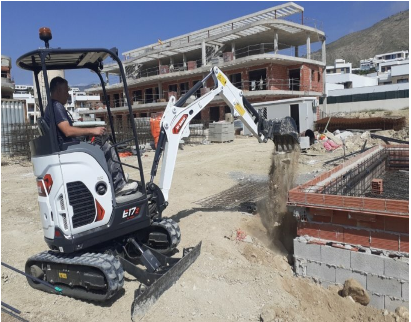
Bobcat E17z mini excavator
