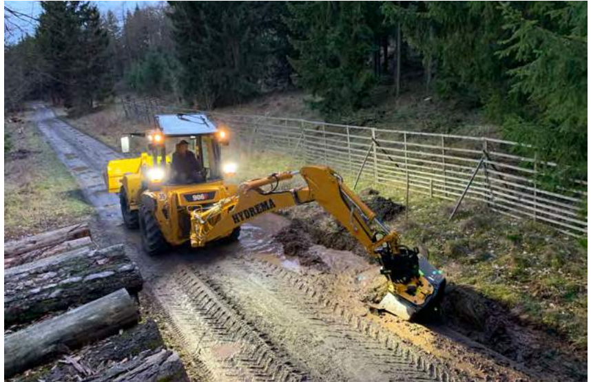
Das Ziehen von Entwässerungsgräben seitlich am Waldweg verläuft sehr einfach mit Blickrichtung auf den Arm
