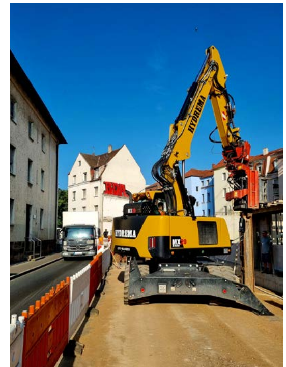
Schwere Bohlen setzen oder ziehen ist mit der Ramme am MX City-Bagger auch in beengten Baustellen möglich.
