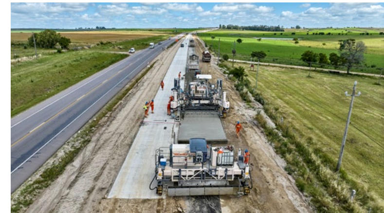
Bei der Erweiterung der Ruta 5, einer der fünf wichtigsten Nationalstraßen in Uruguay, übernahmen Gleitschalungsfertiger und Nachbehandlungsgeräte von Wirtgen den präzisen Betoneinbau. Bildquelle: Wirtgen Group
