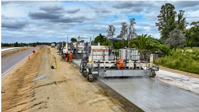
Das Nachbehandlungsgerät TCM 180 fährt direkt hinter dem SP 64 und sorgt bei der Betondecke für die gewünschte Oberflächenstruktur. Das gleichzeitige Aufsprühen von Dispersion verhindert zudem das frühzeitige Austrocknen der Fläche und Kanten. Bildquelle: Wirtgen Group
