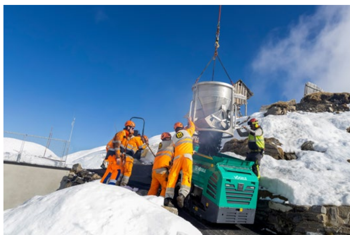
Der Hubschrauber übergab das Mischgut direkt in den Aufnahmebehälter des Vögele Fertigers. Bildquelle: Wirtgen Group
