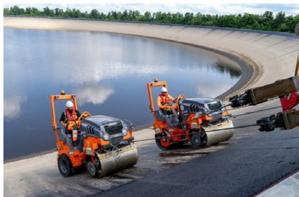
Die Hamm Walzen arbeiteten nicht nur deutlich leiser, sondern auch lokal emissionsfrei. Bildquelle: Wirtgen Group
