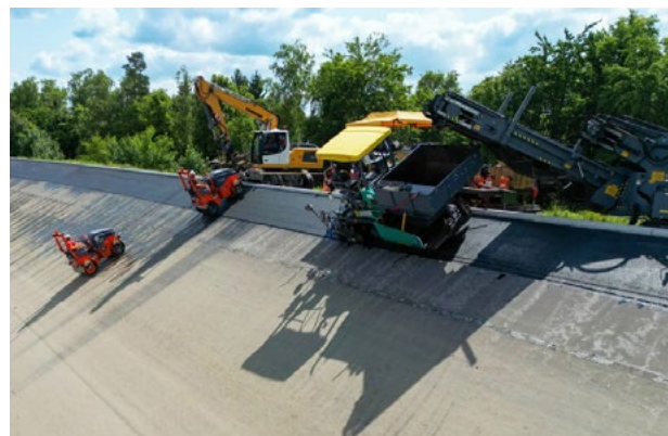
Wirtgen Group Maschinen überzeugen als Gesamtlösung mit besonderem Augenmerk auf die beiden Hamm Walzen, die an der Schräge präzise verdichten. Bildquelle: Wirtgen Group
