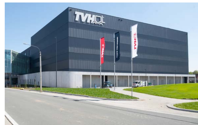
Ein Weitwinkel auf das hochautomatisierte neue TVH-Logistikzentrum. Bildquelle: TVH
