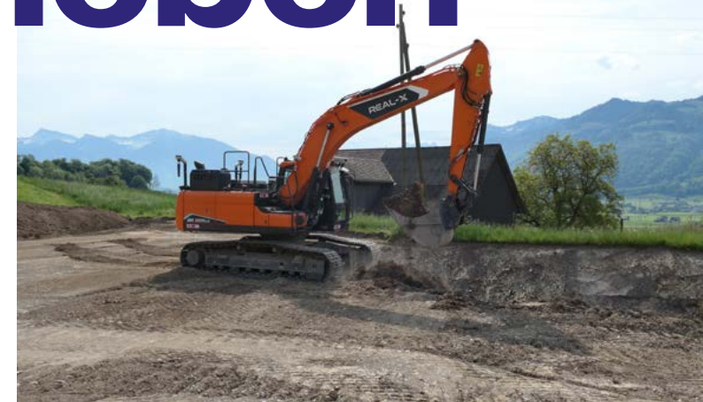
Prächtige Kulisse: Der autonom arbeitende DEVELON-Real-X-Kettenbagger DX225LC beim Praxiseinsatz im ehemaligen Steinbruch der KIBAG im schweizerischen Tuggen. Bildquelle: DEVELON
